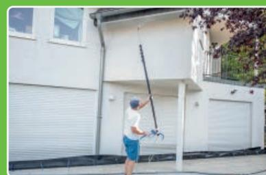
Zum Abschluss versiegeln wir die Fassade mit einem transparenten Langzeitschutz, der Algen, Pilze und Bakterien fernhält – für eine dauerhaft saubere Oberfläche.
