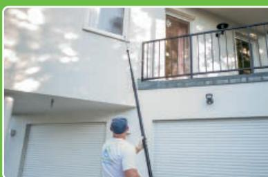
Nach der Einwirkzeit spülen wir die gelösten Verschmutzungen mit klarem Wasser ab. Der Wasserdruck ist dabei schonend eingestellt, um die Fassade nicht zu beschädigen.
